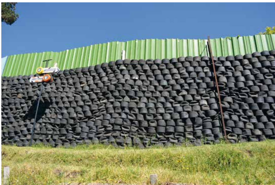
Figura 1. Construcción de barreras artificiales contra el ruido.
